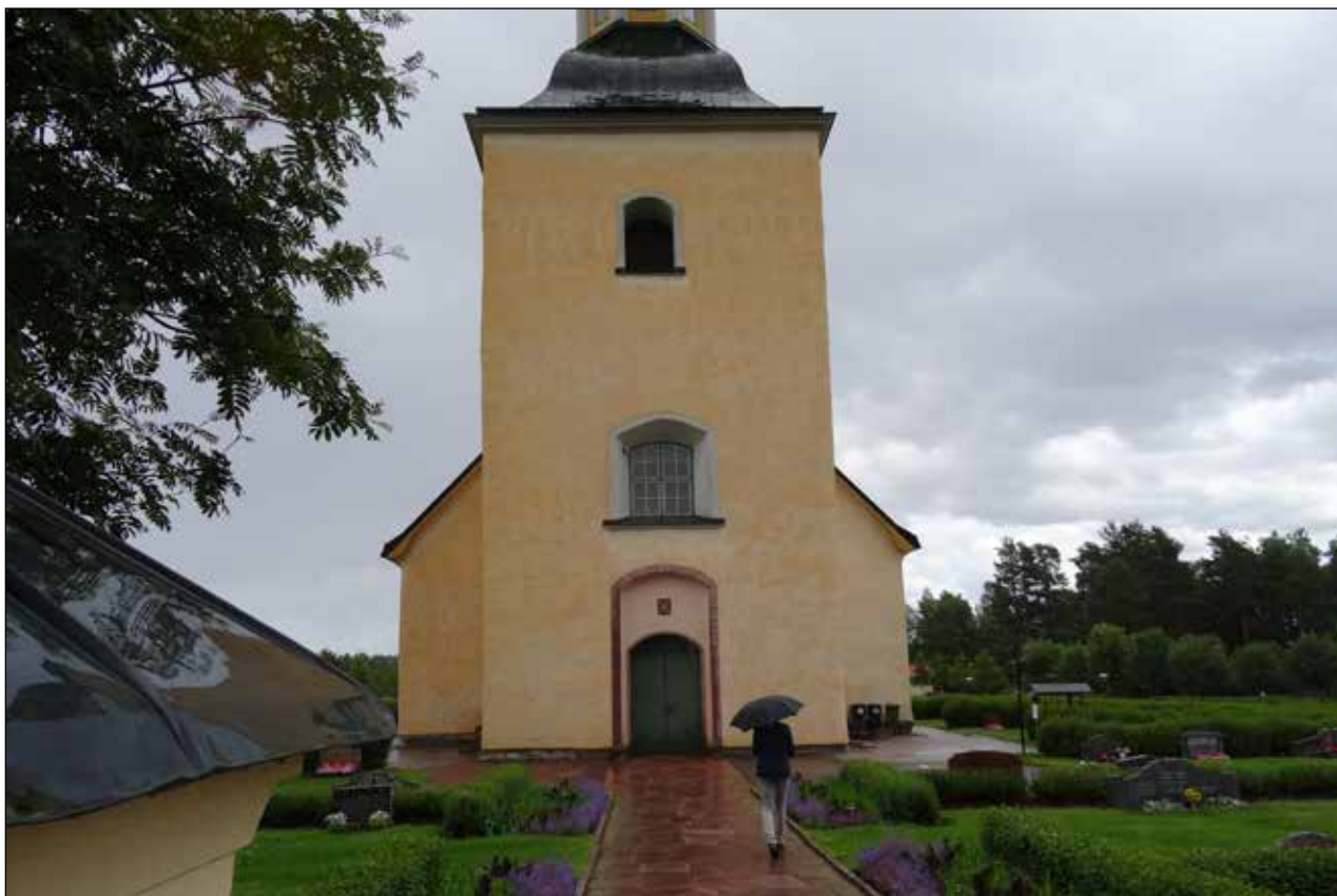
Vämhus kyrka 25 år efter renovering, 2020 07 12.
