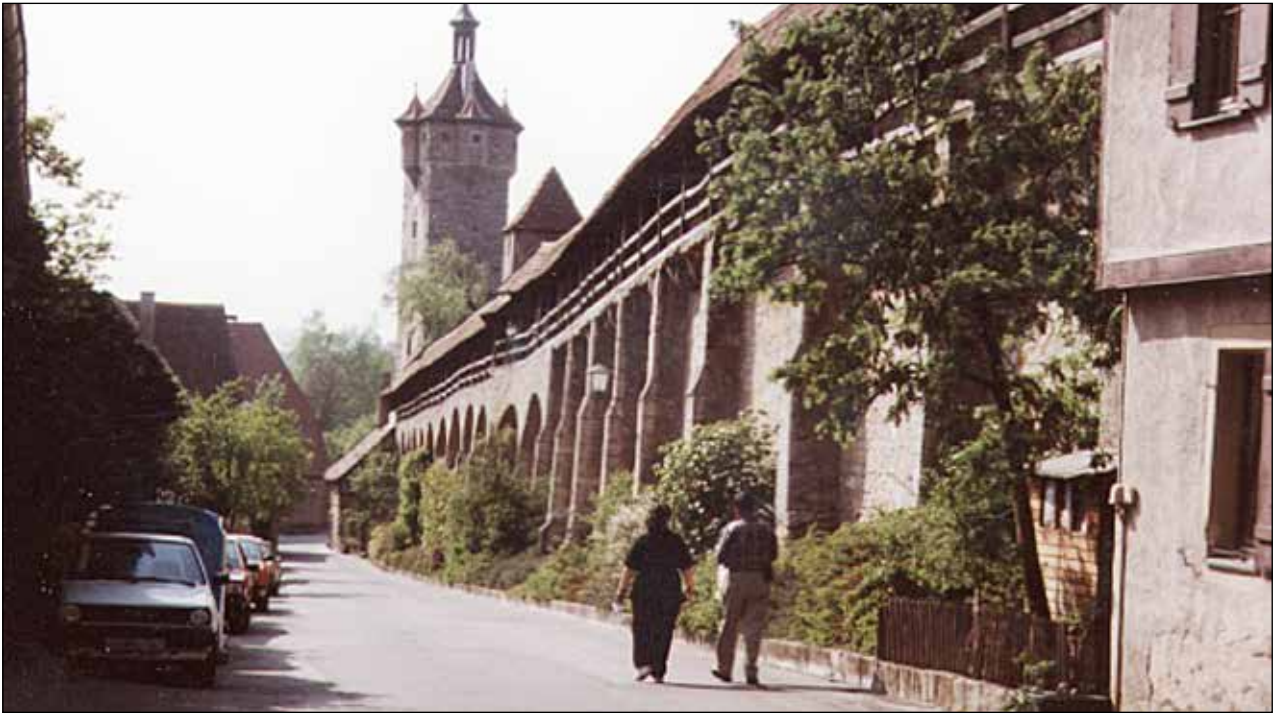
Elastiskt murverk som skyddas under fredstak.
