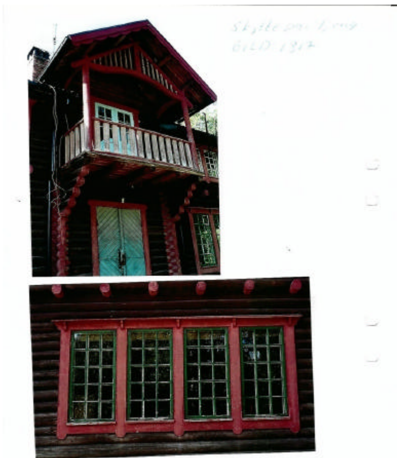
Bild 10. Färgsättning fönster och balkong
